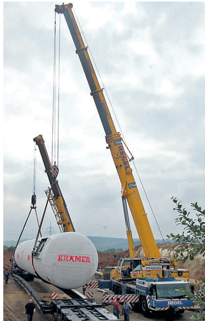
An der langen Leine: 400 000 Liter fasst der über 30 Meter lange Flüssiggastank. Vom Transporter aus verladen ihn die Facharbeiter erst auf ein eigens angelegtes Sandbett, drehen ihn dann und verladen ihn zum Schluss an die geplante Stelle.
